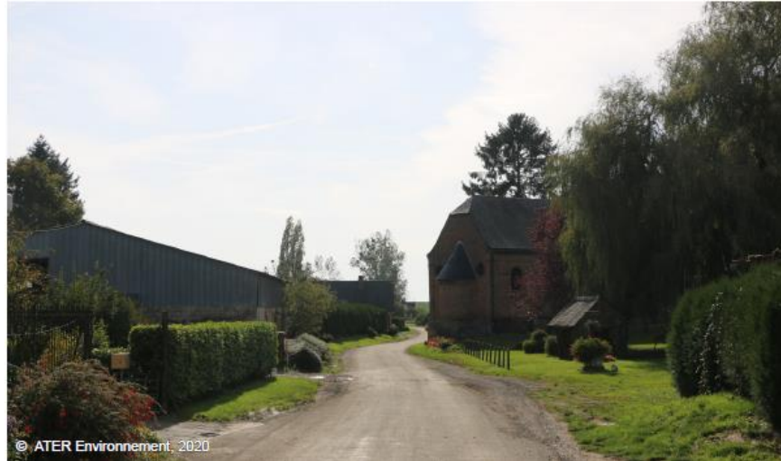
Figure 29 : Photo-simulation de la rue principale de Colonfay après l'enfouissement des lignes électriques
